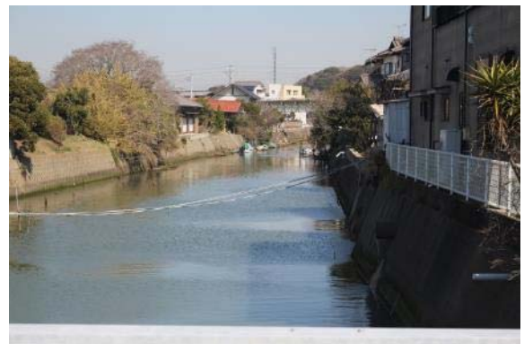
岩瀬橋より上流を写す
