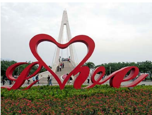
淡水市跨港大橋
